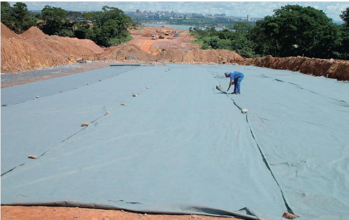
Reforço de sub-leito com manta geotextil
