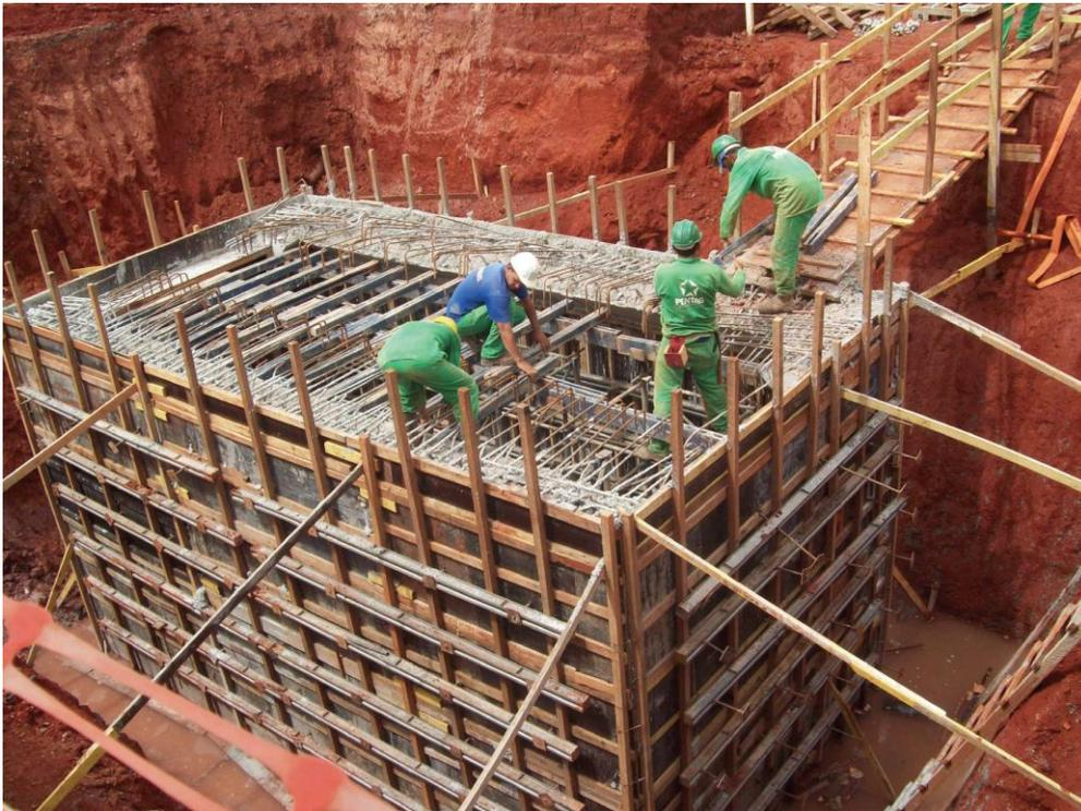
CAIXA DE CONCRETO ARMADO – RETENÇÃO PARA ÁGUA PLUVIAL – SHOPPING CENTER IGUATEMI, BRASÍLIA/DF
